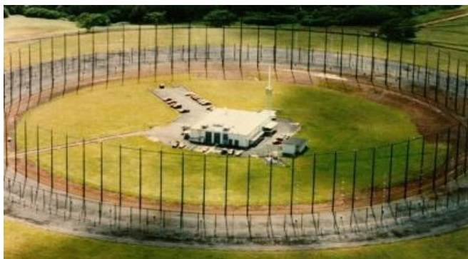
Рис. 1. Большебазисная кольцевая антенная решетка КВ диапазона
