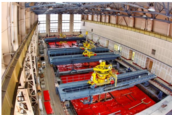
Рис. 2. Испытательный гидроакустический бассейн
